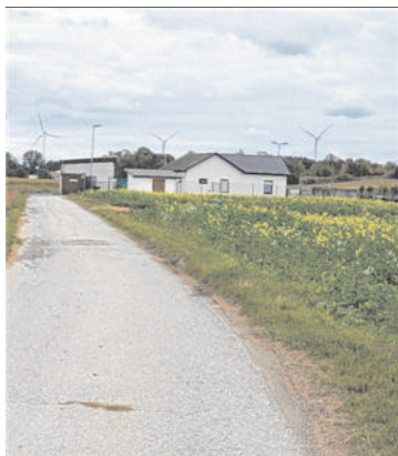
Kapazität. Der Ausbau der Stotzinger Kläranlage ist abgeschlossen.
