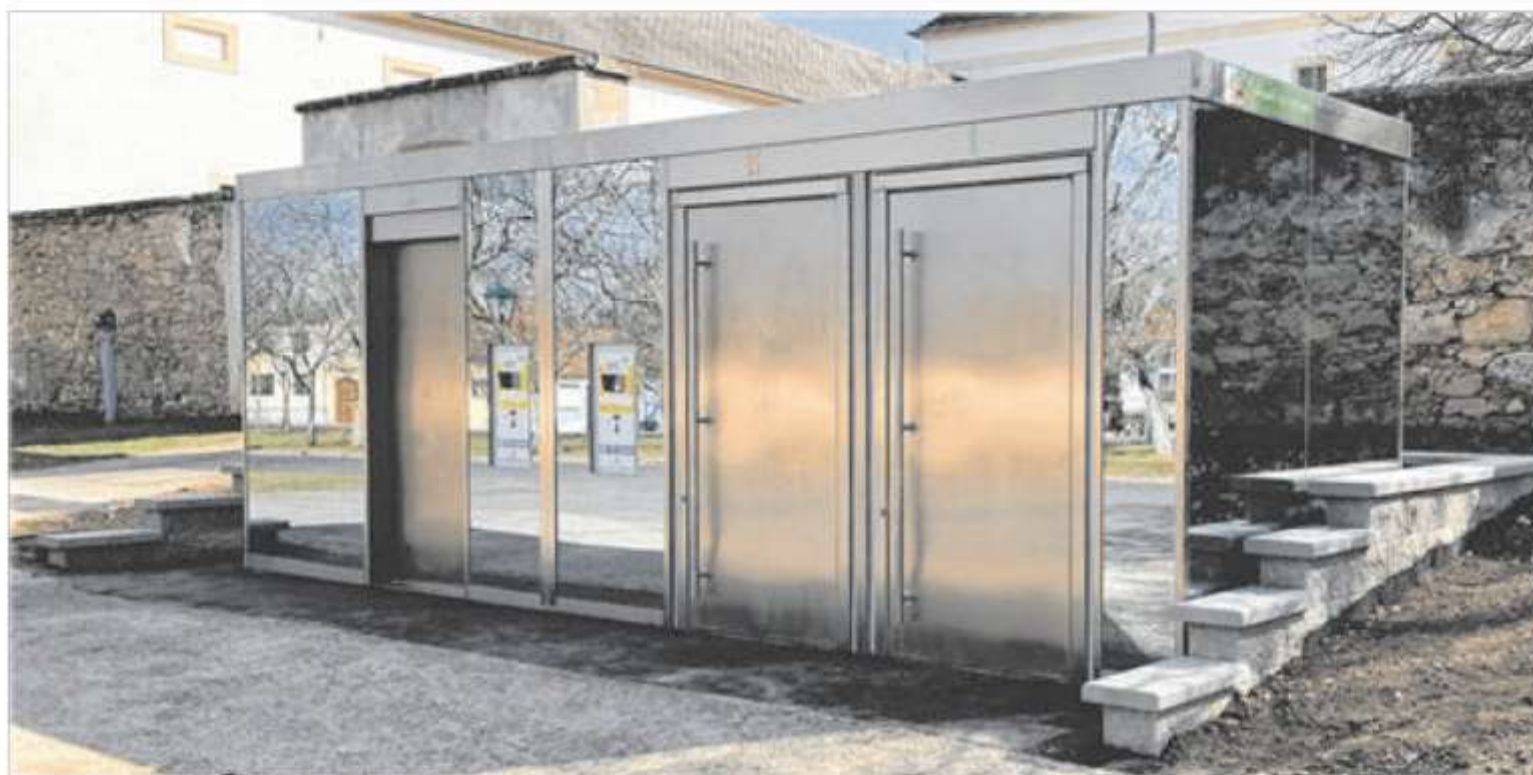
Errichtet. Vor der Basilika in Loretto wurde kürzlich eine neue WC-Anlage für die jährlich tausenden Besucher der Basilika und Märkte errichtet.
