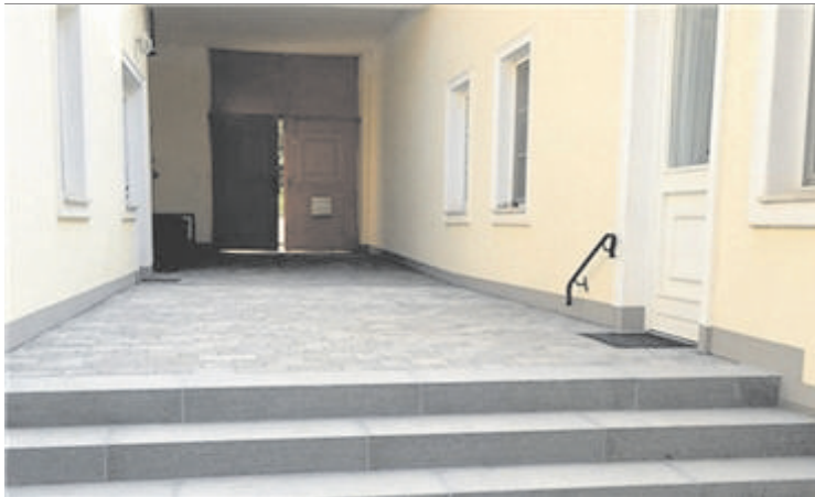
LORETTO | Der Hof der Gemeinde wurde fertiggestellt und die Zugänge zum Gemeindeamt und Standesamt für Gebrechliche und Menschen mit körperlicher Einschränkung barrierefrei. Foto: Gemeinde Loretto
